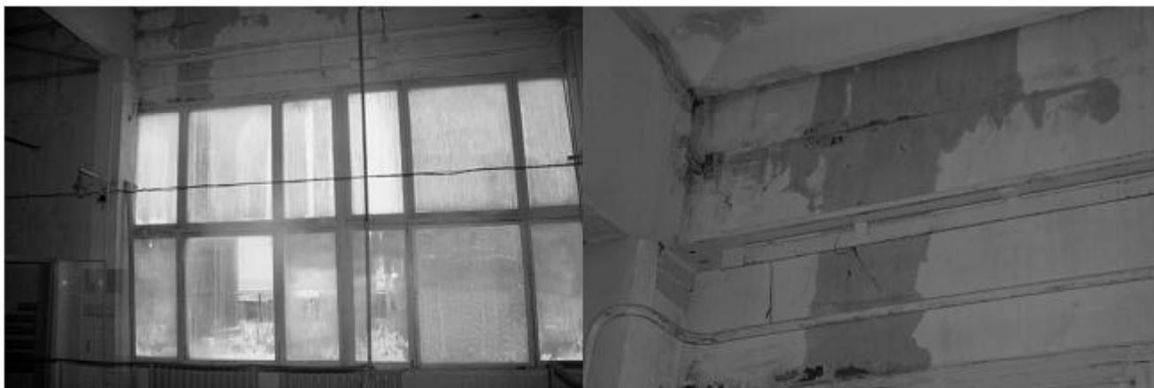
Рисунок – Визуальный осмотр трещин стен и дефектов кровли здания 22
