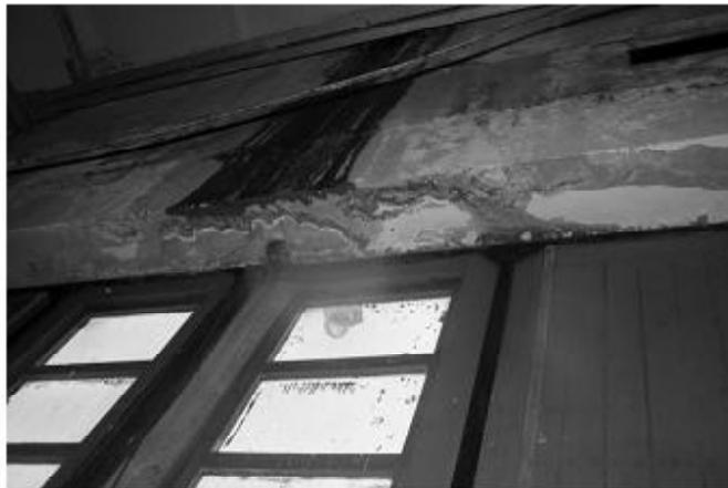
Рисунок – Визуальный осмотр трещин стен и дефектов кровли здания 22
