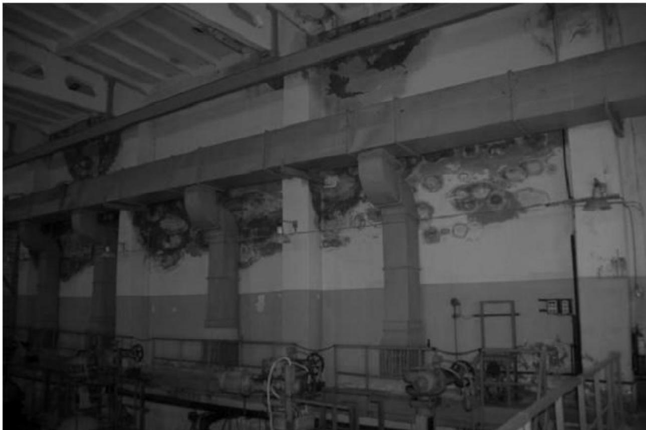
Рисунок – Визуальный осмотр трещин стен и дефектов кровли здания 23 (II подъём)
