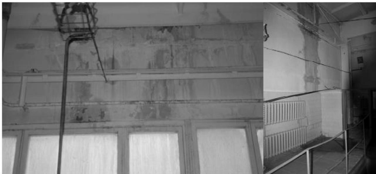
Рисунок – Визуальный осмотр трещин стен и дефектов кровли здания 22
