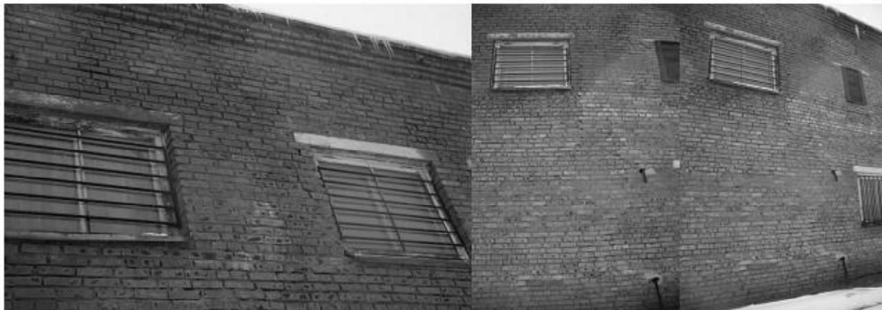
Рисунок – Визуальный осмотр трещин стен здания 25 (хлораторная)
