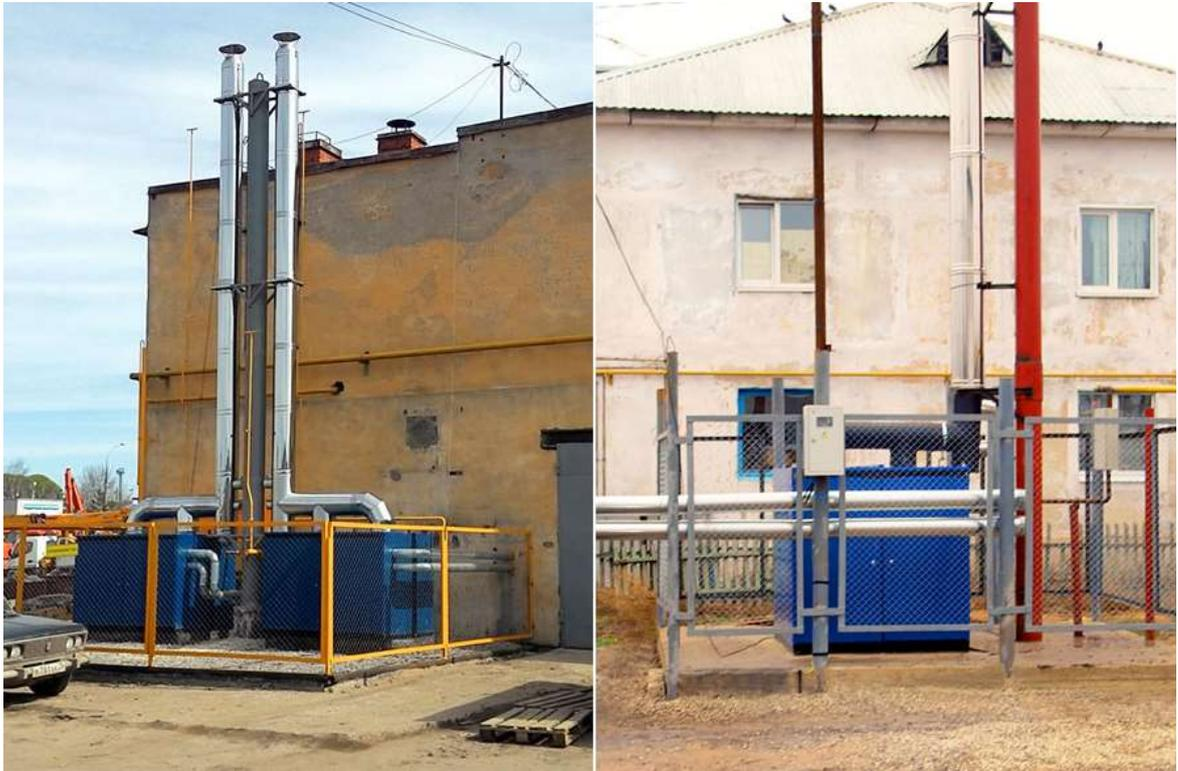
**Рисунок 16 – Примеры использования котлов наружного размещения**
