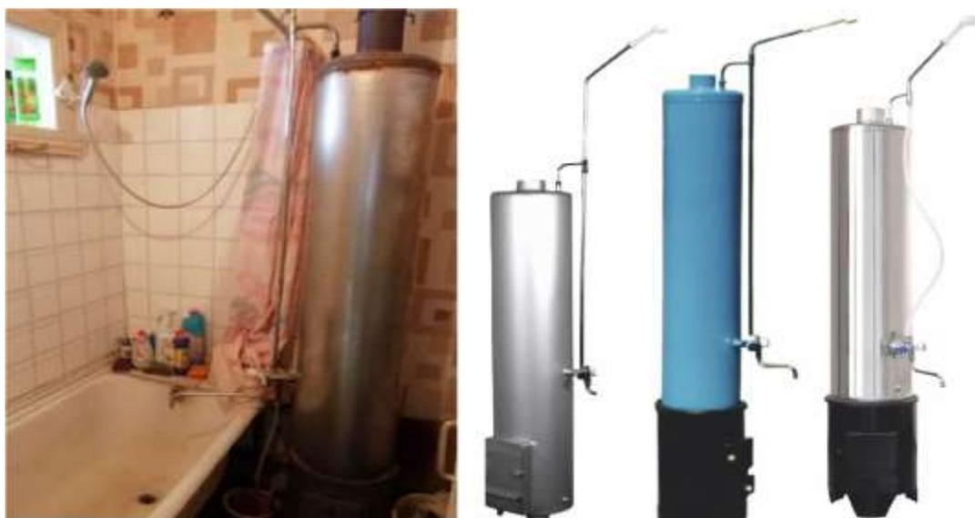
**Рисунок 12 – Дровяная водогрейная колонка «Титан». Пример установки, модели**
