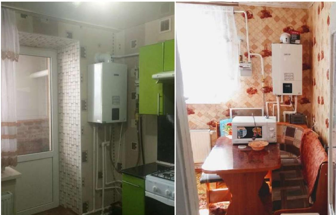
**Рисунок 17 – Примеры использования настенных двухконтурных газовых котлов**
