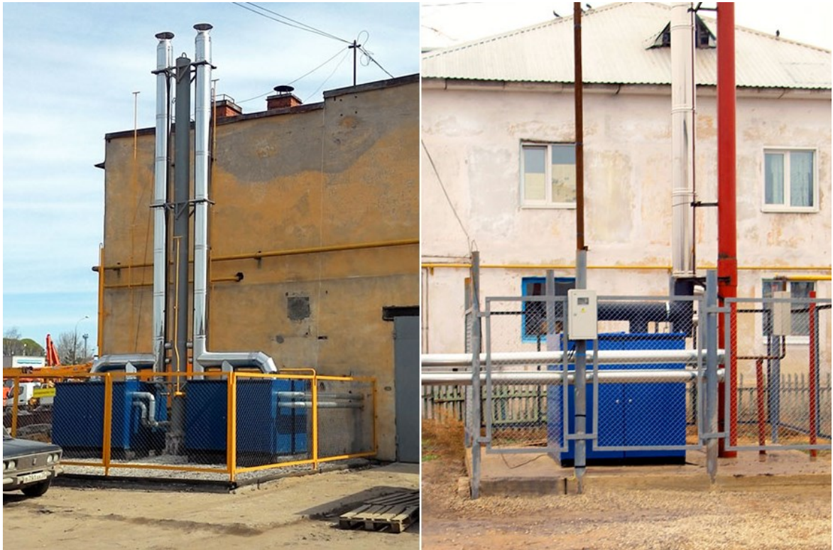
Рисунок 18 – Примеры использования котлов наружного размещения
