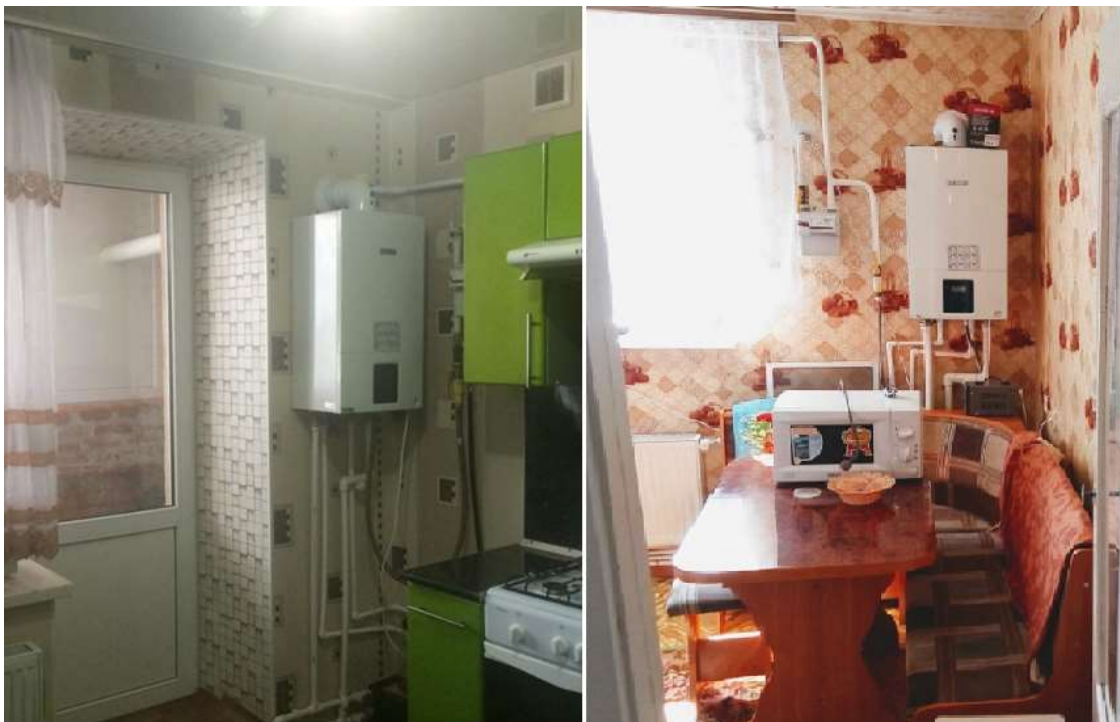
Рисунок 19 – Примеры использования настенных двухконтурных газовых котлов
