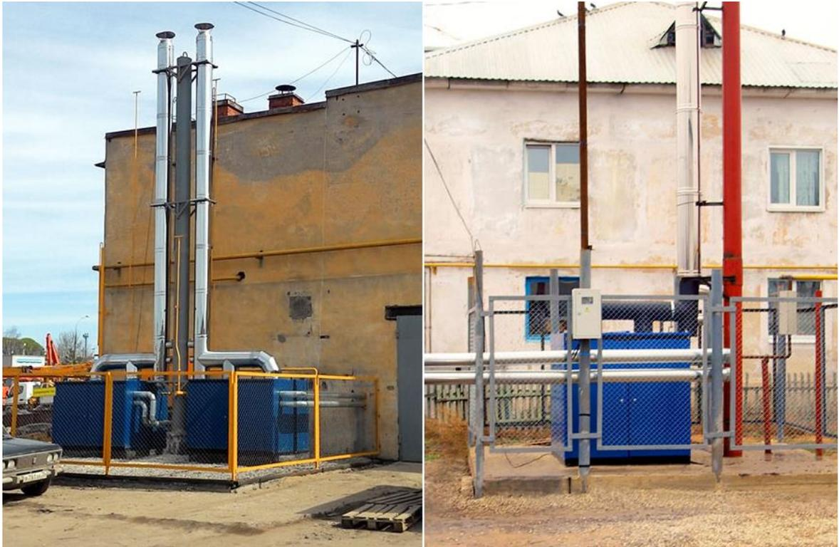
**Рисунок 13 – Примеры использования котлов наружного размещения**
