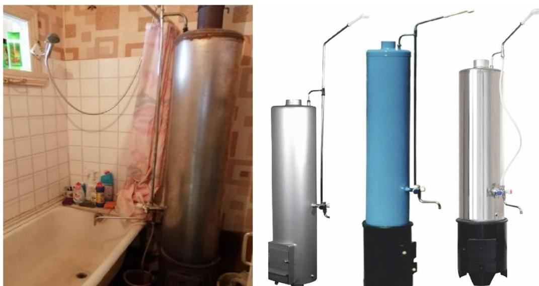
**Рисунок 9 – Дровяная водогрейная колонка «Титан». Пример установки, модели**
