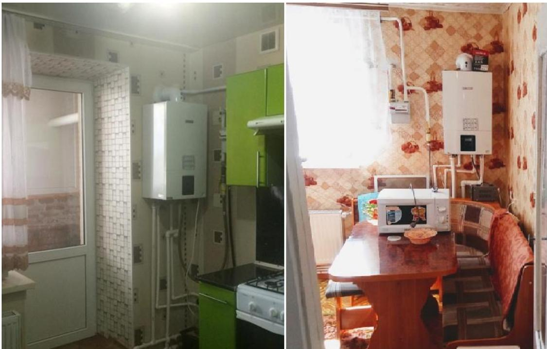
**Рисунок 14 – Примеры использования настенных двухконтурных газовых котлов**
