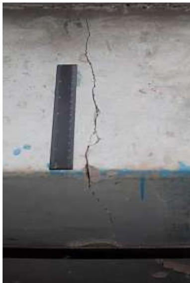
Фото 21 – Визуальный осмотр трещин стен здания 25 (хлораторная)
