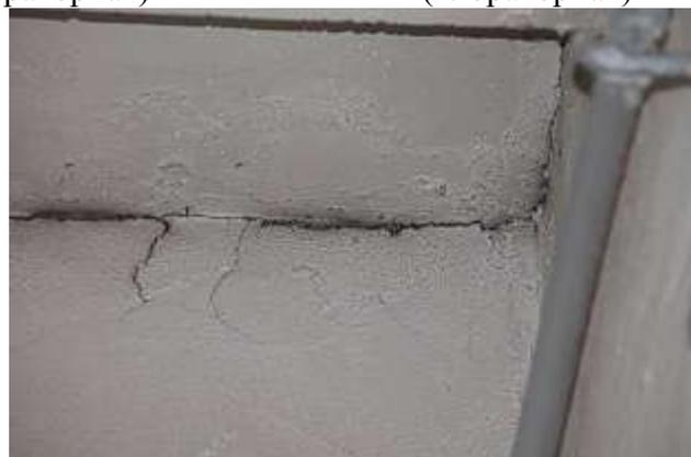
Фото 24 - Визуальный осмотр трещин стен здания 25 (хлораторная)
