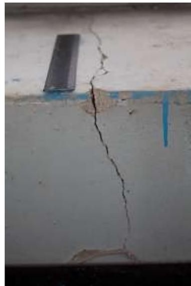
Фото 22 – Визуальный осмотр трещин стен здания 25 (хлораторная)
