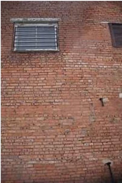
Фото 33 - Визуальный осмотр трещин стен здания 25 (хлораторная)
