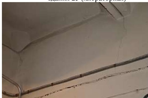
Фото 26 - Визуальный осмотр трещин стен здания 25 (хлораторная)
