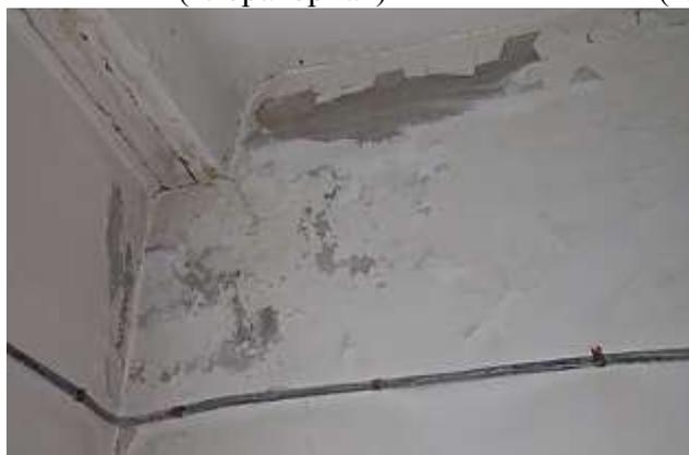
Фото 23 - Визуальный осмотр трещин стен здания 25 (хлораторная)
