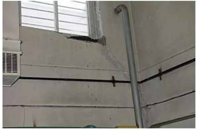
Фото 28 - Визуальный осмотр трещин стен здания 25 (хлораторная)
