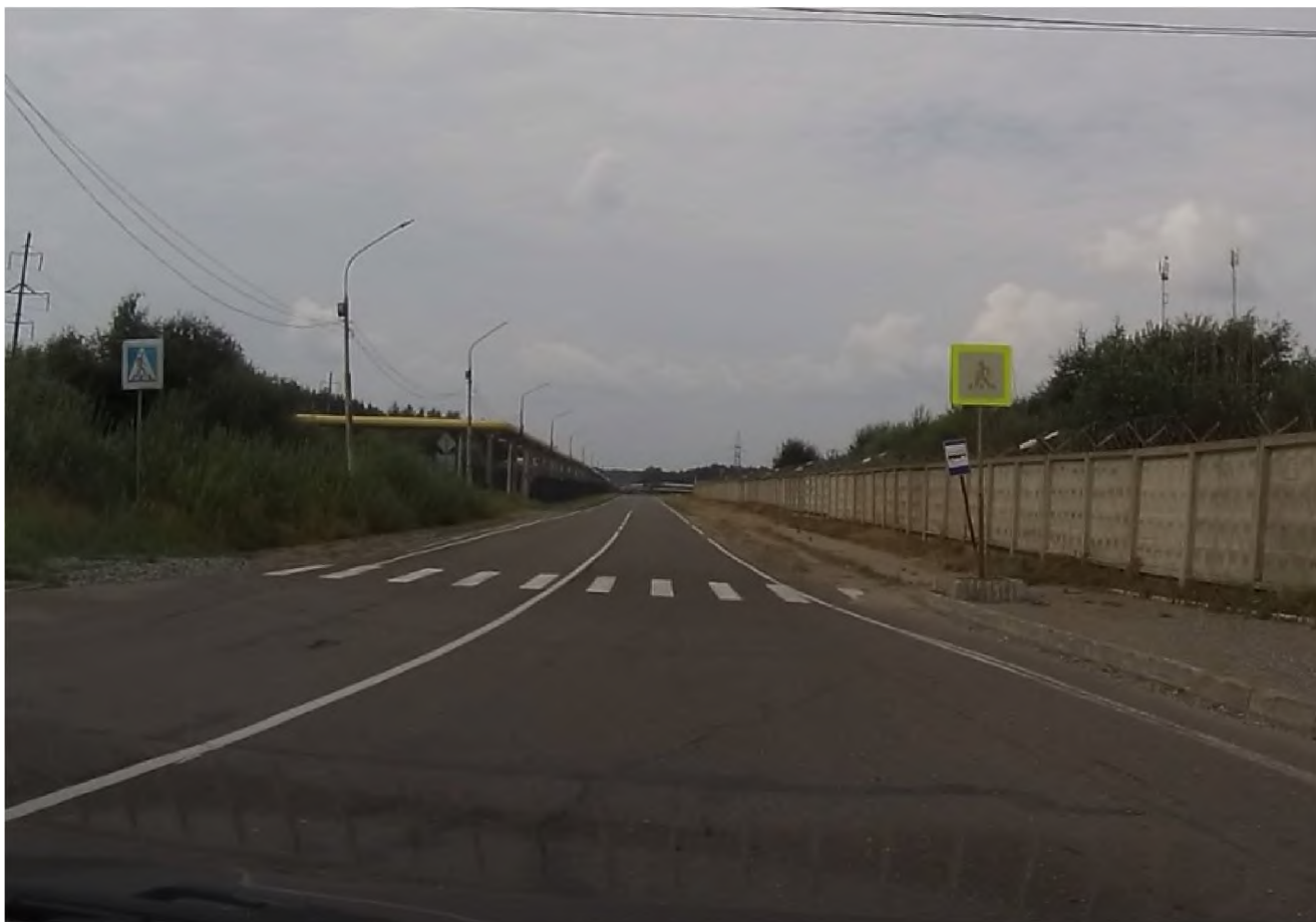
Существующий пешеходный переход, который подлежит демонтажу
