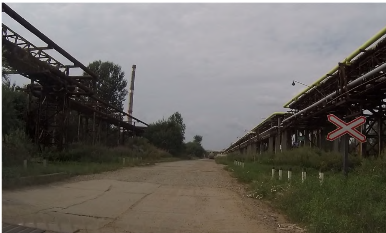
Железнодорожный переезд на автодороге №12
